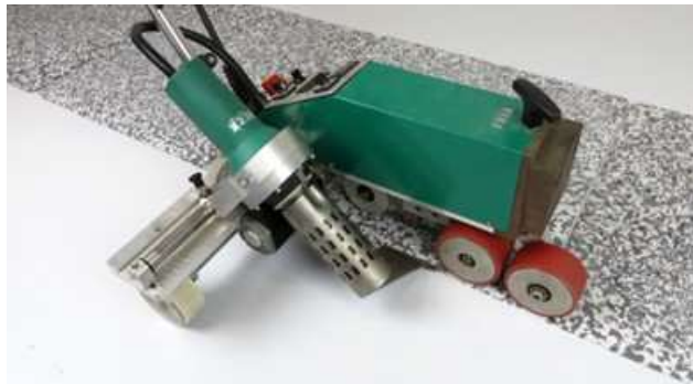
Obr. 1: Navařování dlaždic FATRAFOL WALK 600
