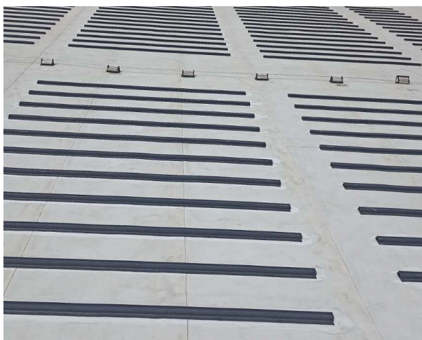
Obr. 9: Navaření profilů FATRAFLEX na plochu střechy
