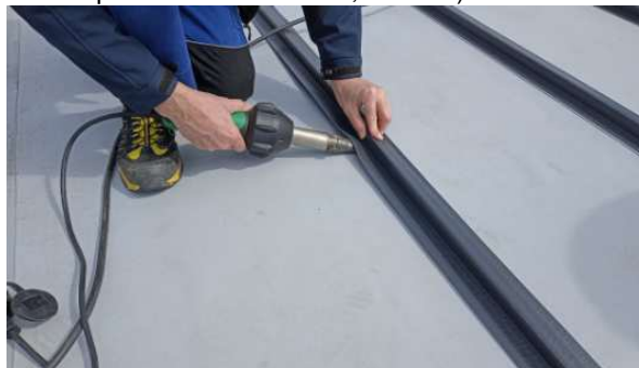
Obr. 8: Fixace profilu bodovými svary
