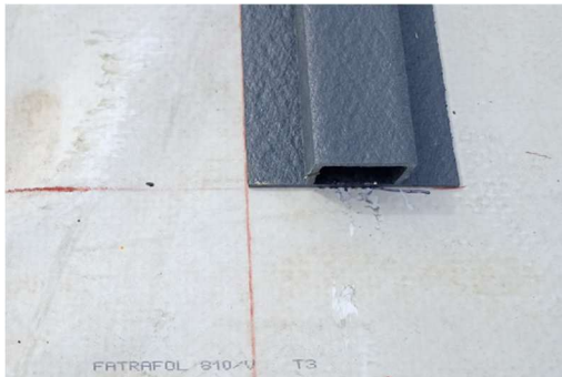
Obr. 7: Umístění profilu podél vytyčené linie
