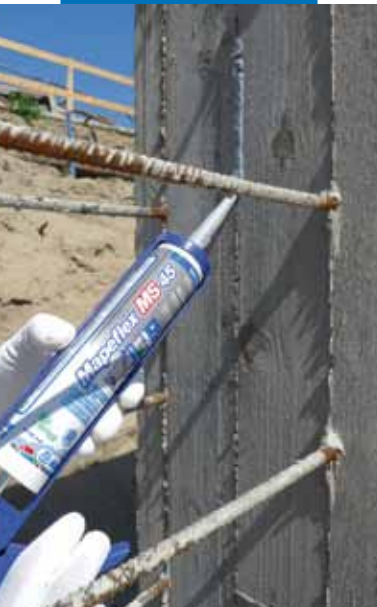
Aplikace Mapeflexu MS45 před instalací Idrostopu Soft před betonáží
