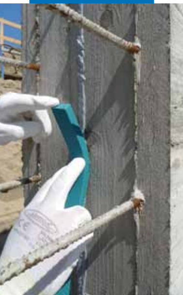
Instalace Idrostopu Soft na svislý povrch
