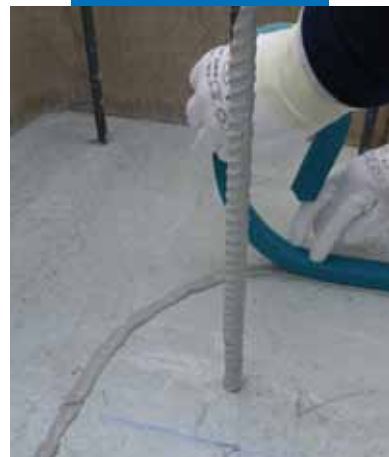
Instalace Idrostopu Soft na vodorovný povrch
