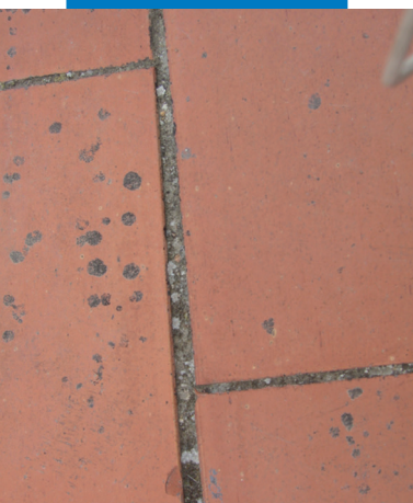
Stará dlažby typu cotto, která vyžaduje úpravu před aplikací Aquaflex Roof
