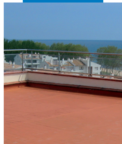
Dlažba na terase zaizolovaná výrobkem Aquaflex Roof
