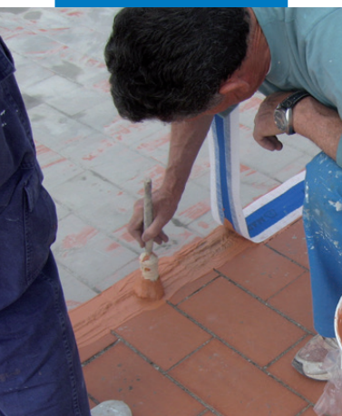
Těsnění dilatačních spár s použitím Mapebandu lepeného k podkladu výrobkem Aquaflex Roof
