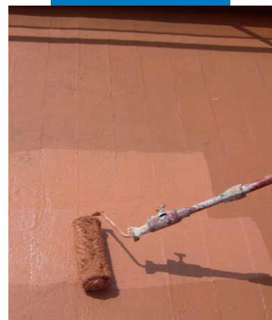
Aplikace Aquaflexu Roof válečkem s dlouhým vlasem
