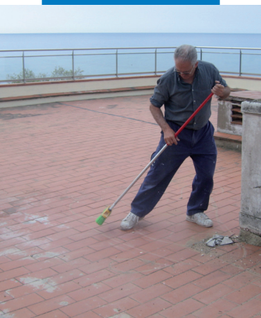
Čištění podkladu před aplikací Aquaflex Roof
