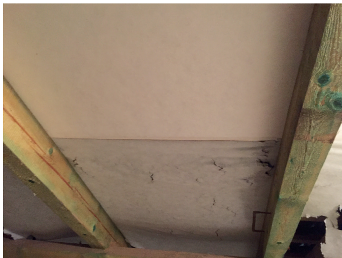
Obrázky: dole: 3vrstvá mikroporézní fólie 135 g/m 2 , nahoře: Tyvek®
