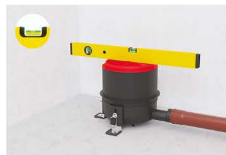
6. Vytvořit spád potrubí, napojit těleso odtoku na odpadní potrubí a vyrovnat pomocí fixačních úhelníků
