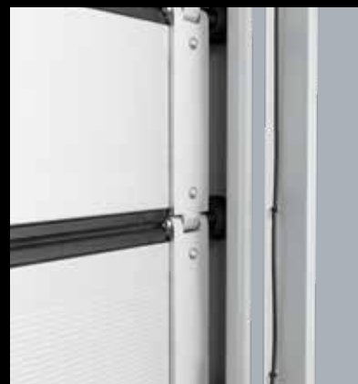
Nízká hladina hluku a minimální opotřebení díky válečkům připevněným k řetězu závěsu.
